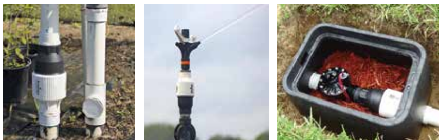
Installez-le toujours en aval de tous les robinets d'arrêt.
