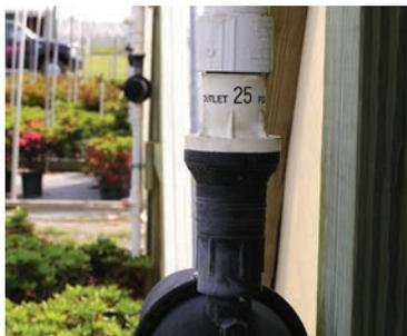
Le PR-HF (Pressure Regulator High Flow) est la solution idéale pour les installations nécessitant des débits plus élevés de l'ordre de 10 à 32 gpm (2 271 à 7 268 L/hr), notamment les arroseurs à couverture intégrale et les collecteurs à espace réduit.
